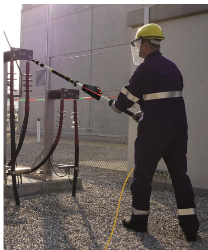
Měření se zkoušečkou HS 36 na 36 kV
